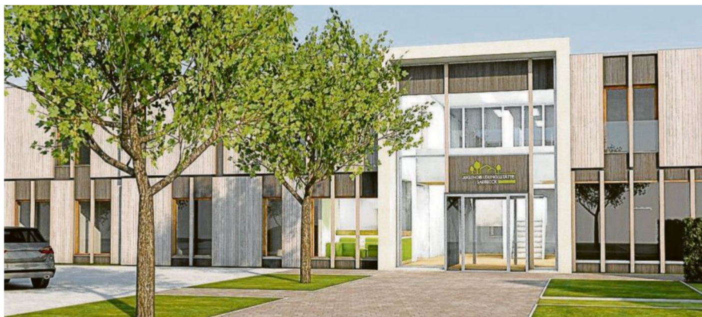
Zwei Jahre wird's noch dauern, bis die Jugendbildungsstätte in Westladbergen so aussieht: Top-modern, nachhaltig gebaut, CO2-neutral. Zeichnung: PDA
